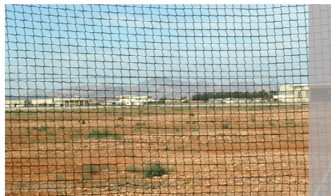
Filet polyéthylène de la clôture amagnétique
